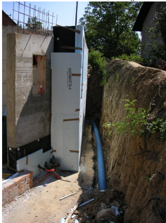
Slika 3-6: Korito, drenažna cev, geotekstil na prekop in rečni gramoz 3 Slika 3-7: Polaganje drenaže 4
