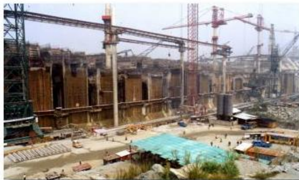
Slika 3-5: Gradbišče prelivnega dela pregrade z 22 prelivnimi polji (ena odprtina predstavlja eno prelivno polje) 5 Slika 3-5: Gradbišče levoobrežne strojnice 6
