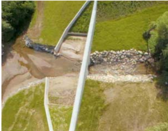
Slika 2-5: Pregrada slikana od zgoraj 1
