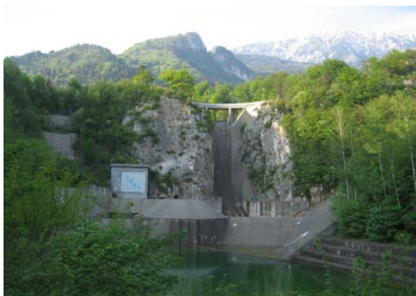
Slika 5-5: Ločna pregrada Moste 4
