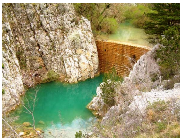
Slika 2-14: Kamena pregrada v kanjonu Badnjevice 5
