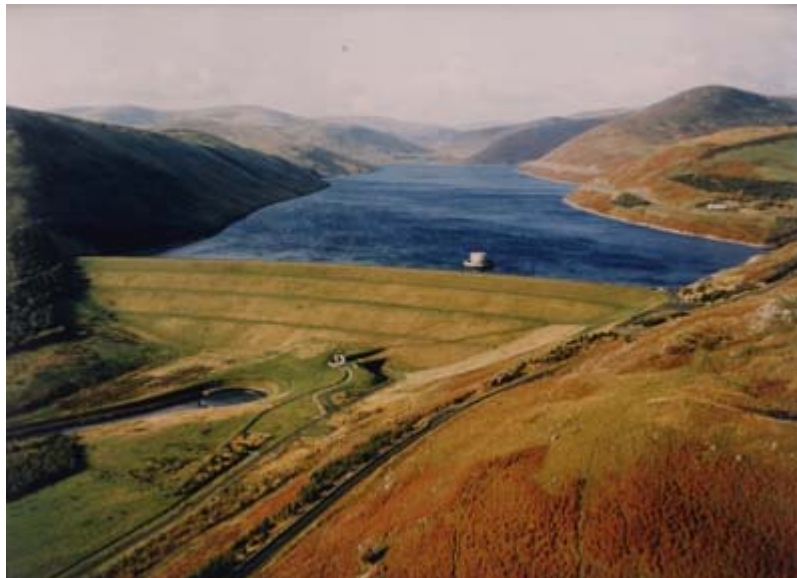
Slika 3-24: Zemeljska pregrada Megget 12
