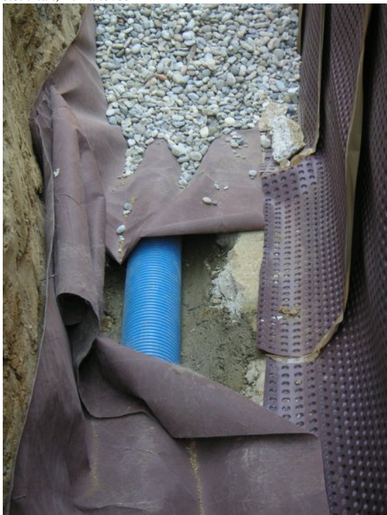
Slika 3-6: Korito, drenažna cev, geotekstil na prekop in rečni gramoz 3 Slika 3-7: Polaganje drenaže 4
