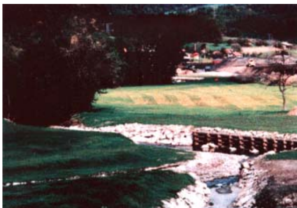
Slika 6-16: Vodne zgradbe-obrežno zavarovanje
