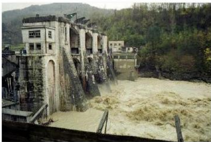
Slika 3-66: Primer steberne pregrade Ajba 15
