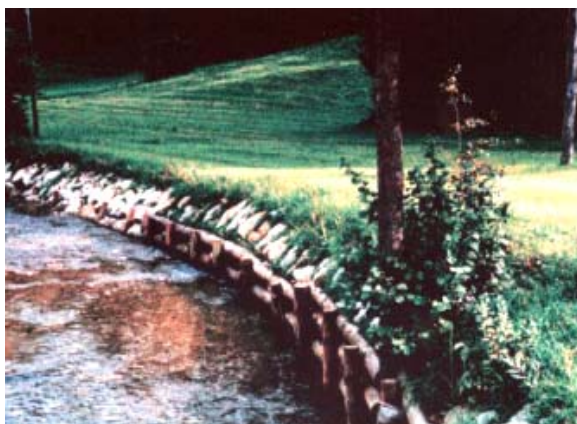
Slika 6-17: Vodne zgradbe-obrežno zavarovanje
