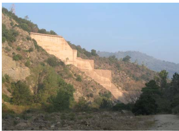
Slika 2-16: Pregrada Malpasset – porušena ločna pregrada
