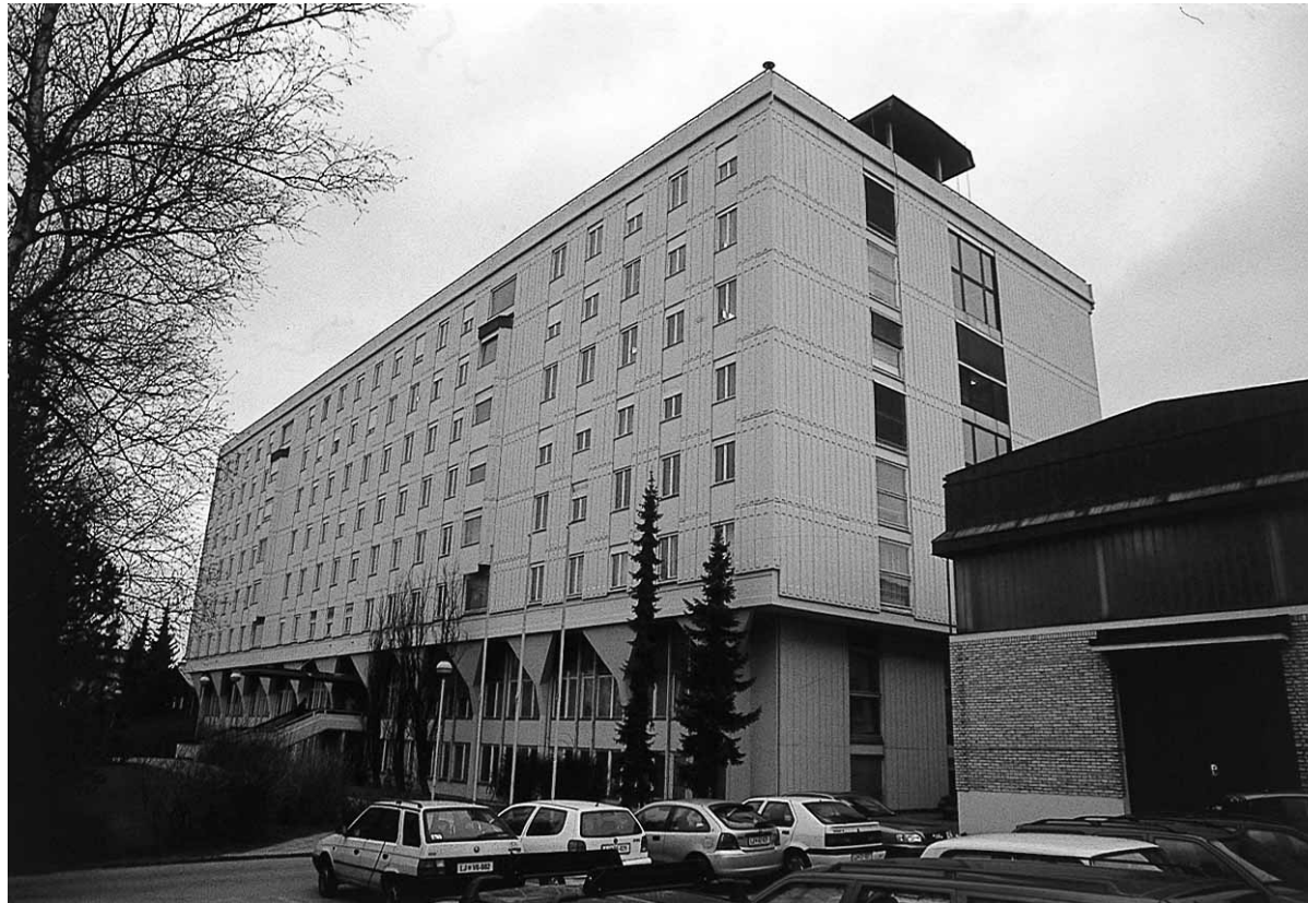
Zgradba Fakultete za gradbeništvo in geodezijo Univerze v Ljubljani na Jamovi cesti 2, Ljubljana. Desno laboratorij za preskušanje materialov in konstrukcij.
