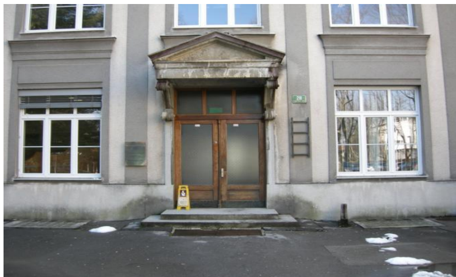
Vzhodni portal na Hajdrihovi ul. 28 pred sanacijo ...
