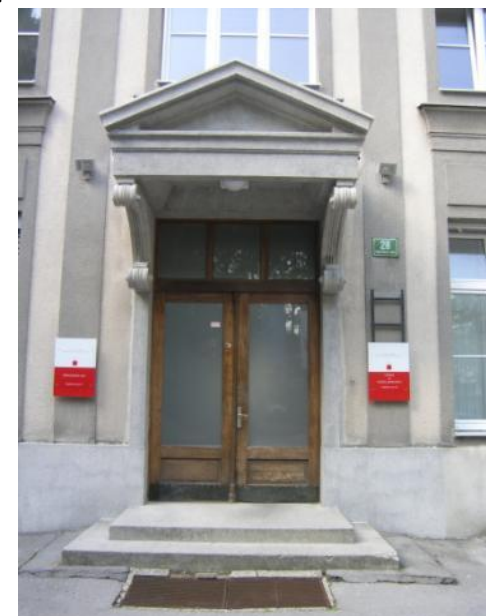
... in po sanaciji.
