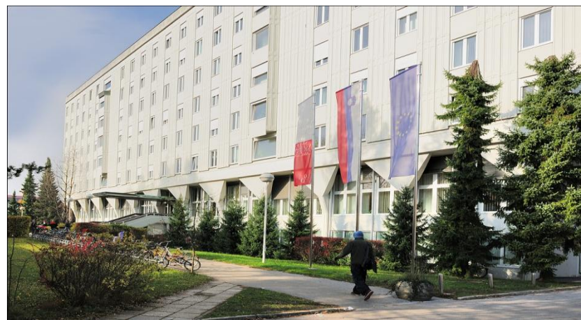
Zgradba Fakultete za gradbeništvo in geodezijo Univerze v Ljubljani na Jamovi cesti 2, Ljubljana.
