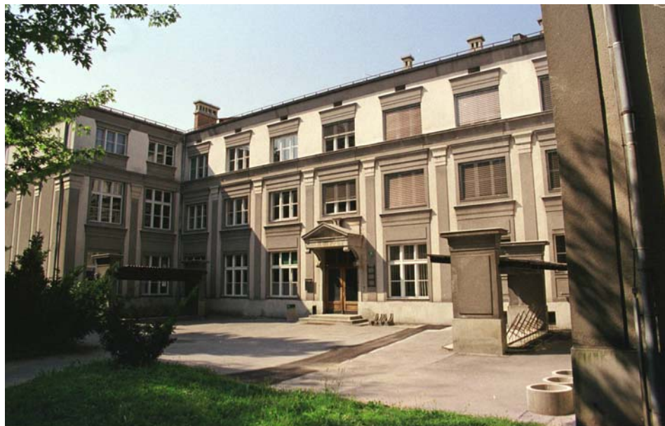
Zgradba Fakultete za gradbeništvo in geodezijo na Hajdrihovi 28, Ljubljana. V njej je Hidrotehnična smer FGG UL in v tej zgradbi poteka univerzitetni študij vodarstva in komunalnega inženirstva.
