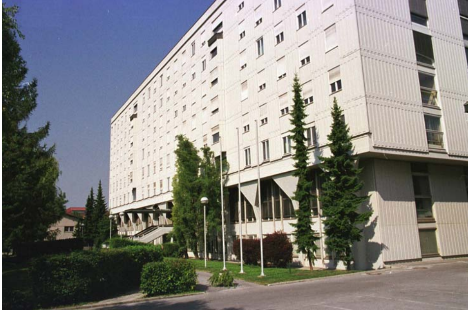
Zgradba Fakultete za gradbeništvo in geodezijo na Jamovi cesti 2, Ljubljana. Desno laboratorij za preskušanje materialov in konstrukcij.
