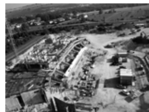
Betoniranje 1. In 2. Dilatacije na koti +5.50. Na desni strani slike zemeljska dela in izkop za temelje dilatacije 14.
