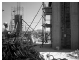
Betoniranje 1. In 2. Dilatacije na koti +5.50. Na desni strani slike zemeljska dela in izkop za temelje dilatacije 14.
