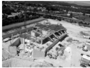
Dvorana je razdeljena na 16 delovnih etap (dilatacij). Na sliki vidimo armiranje plošče v dil. 1 na koti +1.00. Med gradnjo bo zabetoniranega cca 28.000 m 3 .
