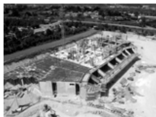
Dil. 1. Do 3. Na koti +1.00, stopničasti nosilec ter monolitni del tribune
