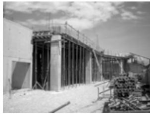
Dvorana je razdeljena na 16 delovnih etap (dilatacij). Na sliki vidimo armiranje plošče v dil. 1 na koti +1.00. Med gradnjo bo zabetoniranega cca 28.000 m 3 .
