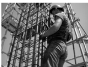
Armiranje stebra dim 60x80. V dvorani bo vgrajene cca 4500 t armature.
