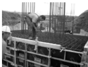
Armiranje točkovnega temelja
