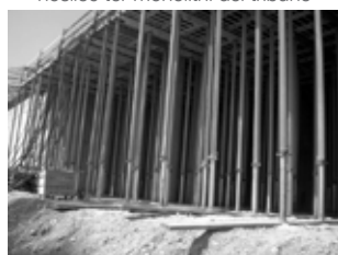
Opaževanje plošče s pomočjo podpornih nosilcev. Na sliki so vidni še kablji za prednapenjanje.
