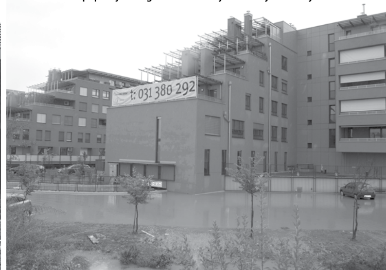
Viška Sončava s poplavljenimi garažami – nekaj stanovanj še na voljo.
