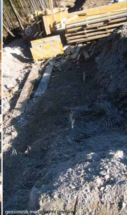
geosintetik med plasti zemljine
