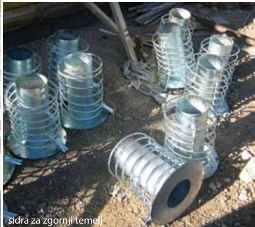
opaž in armatura za zgornji temelj oz. odskočno mizo
