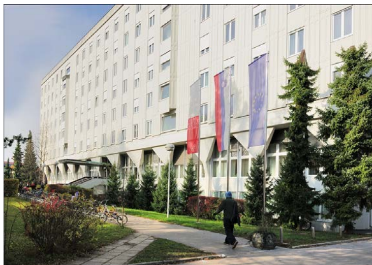
Zgradba Fakultete za gradbeništvo in geodezijo Univerze v Ljubljani na Jamovi cesti 2, Ljubljana.
