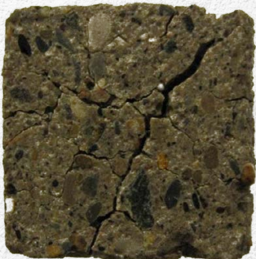
Notranje poškodbe betona zaradi zmrzovanja
