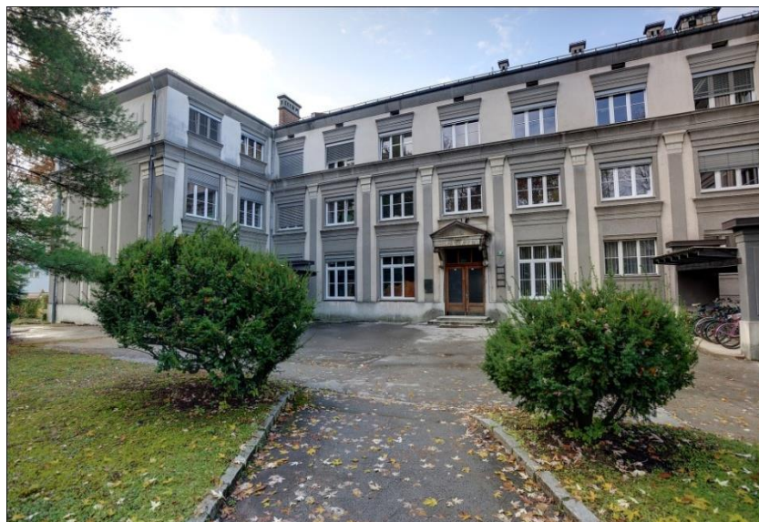
Zgradba Fakultete za gradbeništvo in geodezijo Univerze v Ljubljani na Hajdrihovi ulici 28 v Ljubljani.
