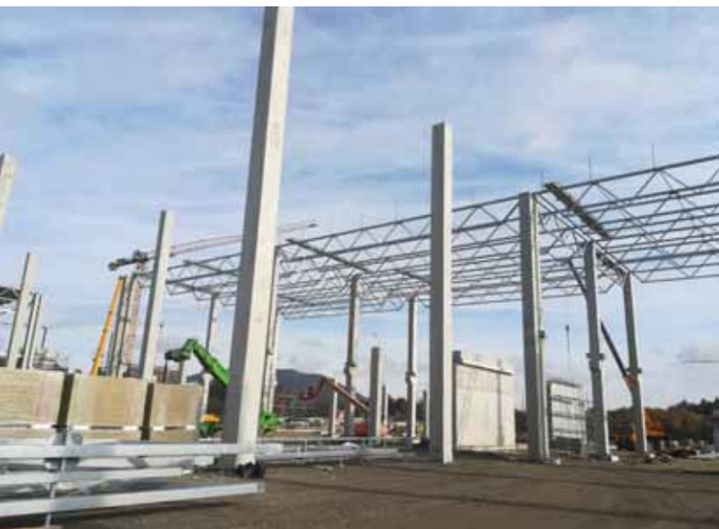
Pogled na logistični center med gradnjo in po njej.
