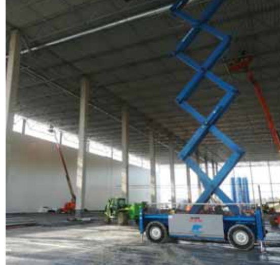
Gradnja logističnega centra hitro napreduje; ponekod se že izvajajo instalacije za prezračevanje in sprinklerski sistemi za gašenje v primeru požara.
