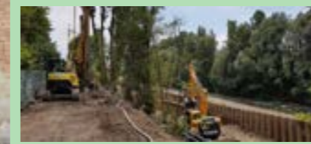
Lamelna izvedba jet grouting Soilcrete® kot vertikalni tesnilni element (Tesnenje z JG na Projektu Murkraftwerk, Graz)
