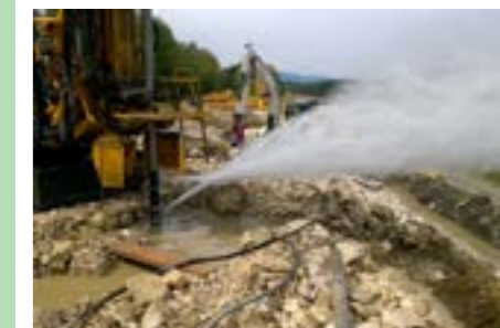
Vrtna garnitura KB6 s posebej za projekt razvitim Duplex monitorjem Keller-DX z dvema šobama premera 6,0 mm in 4,2 mm (Stabilizacija tal za izvedbo žel. tunela, St. Kanzian, Avstrija)
