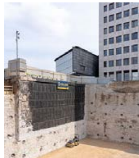
JG Soilcrete® kot podporni element AB temeljne plošče telekomove podzemne centrale (Zavarovanje gradbene jame z JG Soilcrete® na projektu A-Tower, Lj)
