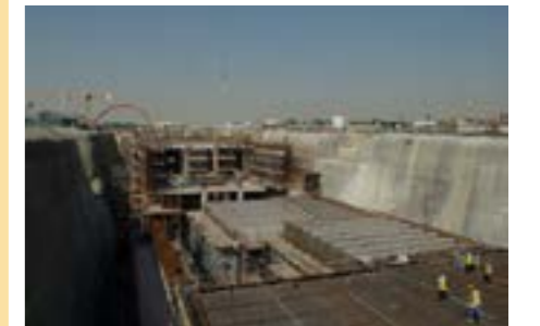
Gradnja podzemne železnice v Dohi, Katar
