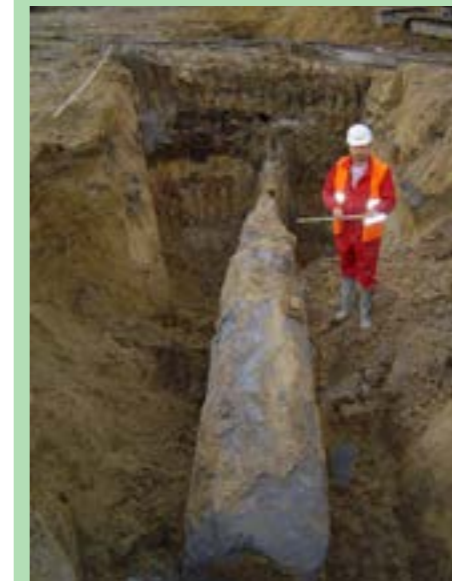
Lamelna izvedba jet grouting Soilcrete® kot vertikalni tesnilni element (Tesnenje z JG na Projektu S8, Varšava)
