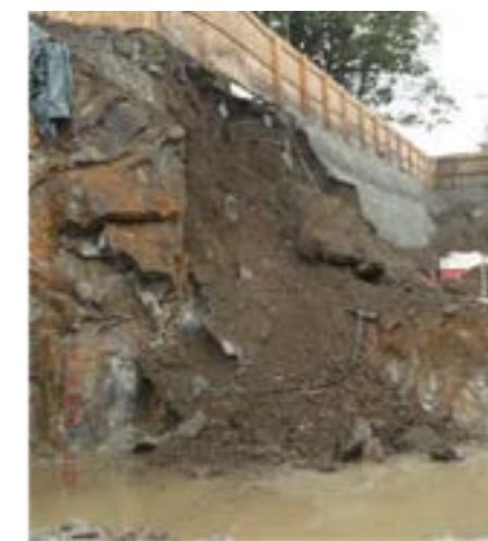
Porušitev začasnega nasipa
