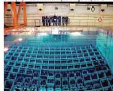
Bazen v notranjosti jedrske elektrarne, ki zmanjšuje radioaktivnost jedrskega odpadka
