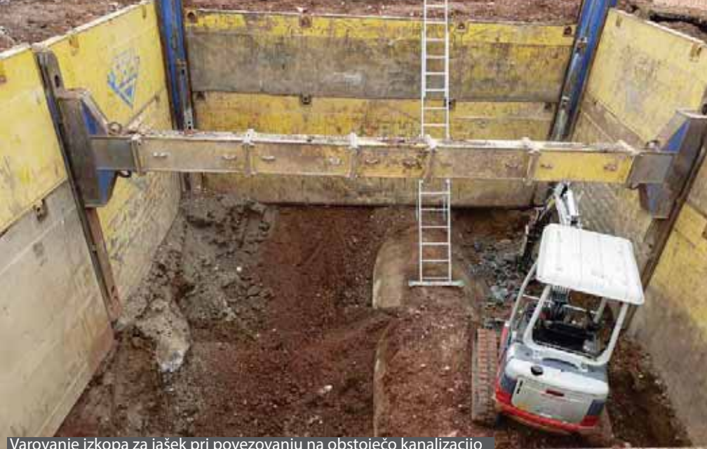
Varovanje izkopa za jašek pri povezovanju na obstoječo kanalizacijo
