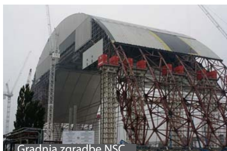
Gradnja zgradbe NSC
