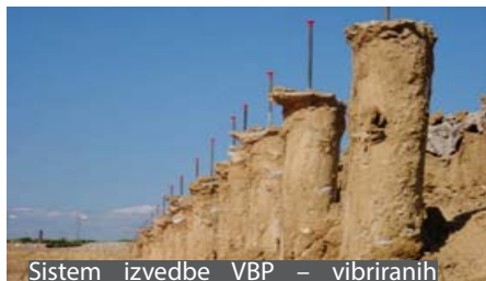
Sistem izvedbe VBP – vibriranih betonskih pilotov
