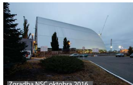
Zgradba NSC oktobra 2016
