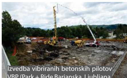
Sistem izvedbe VBP – vibriranih betonskih pilotov
