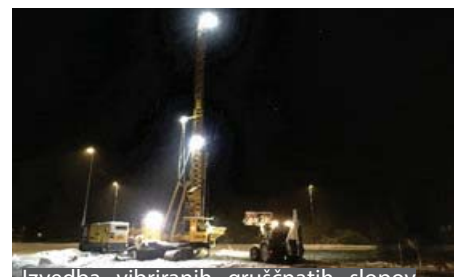
Izvedba vibriranih gruščnatih slopov VGS v kombinaciji s predobremenilnim nasipom (Poslovno-proizvodni objekt Blatnik, Škofljica, 2018)
