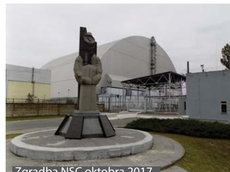
Zgradba NSC oktobra 2017
