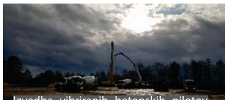
Izvedba vibriranih betonskih pilotov VBP (Stanovanjska soseka Jurčkova, Ljubljana, 2019/20)
