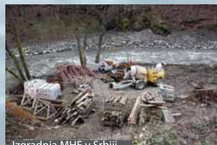
Izgradnja MHE v Srbiji
