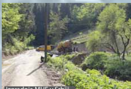
Izgradnja MHE v Srbiji
