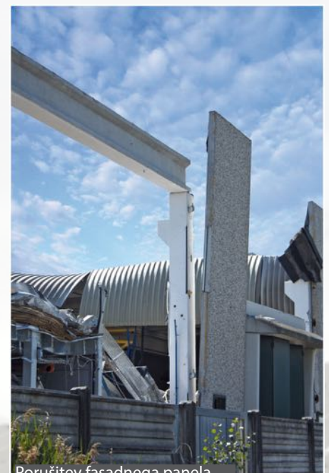
Porušitev fasadnega panela
