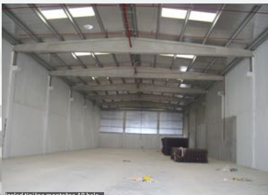
Izgled tipične montažne AB hale
