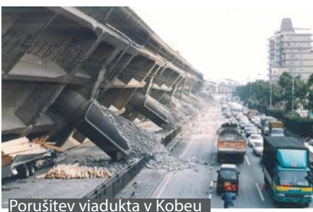
Porušitev viadukta v Kobeju
