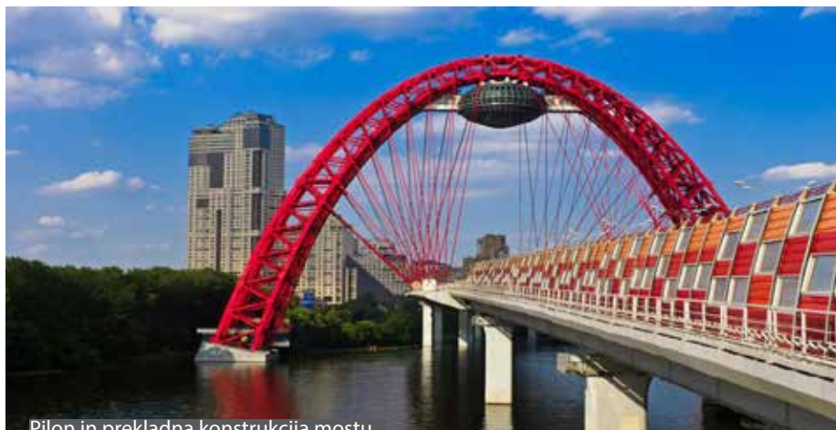
Pilon in prekladna konstrukcija mostu
