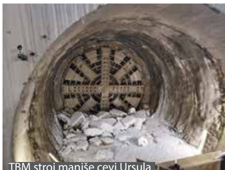
TBM stroj manjše cevi Ursula
