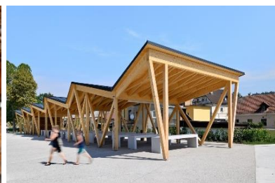
Ureditev tržnice v Medvodah Arhitektura: 3Biro Foto: Miran Kambič
