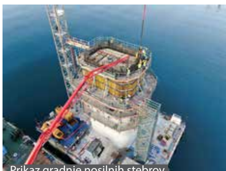
Prikaz gradnje nosilnih stebrov
