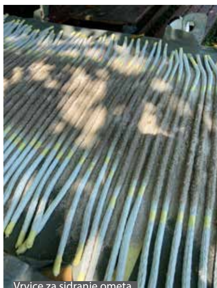
Vrvice za sidranje ometa
