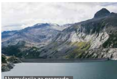
Akumulacija za pregrado
