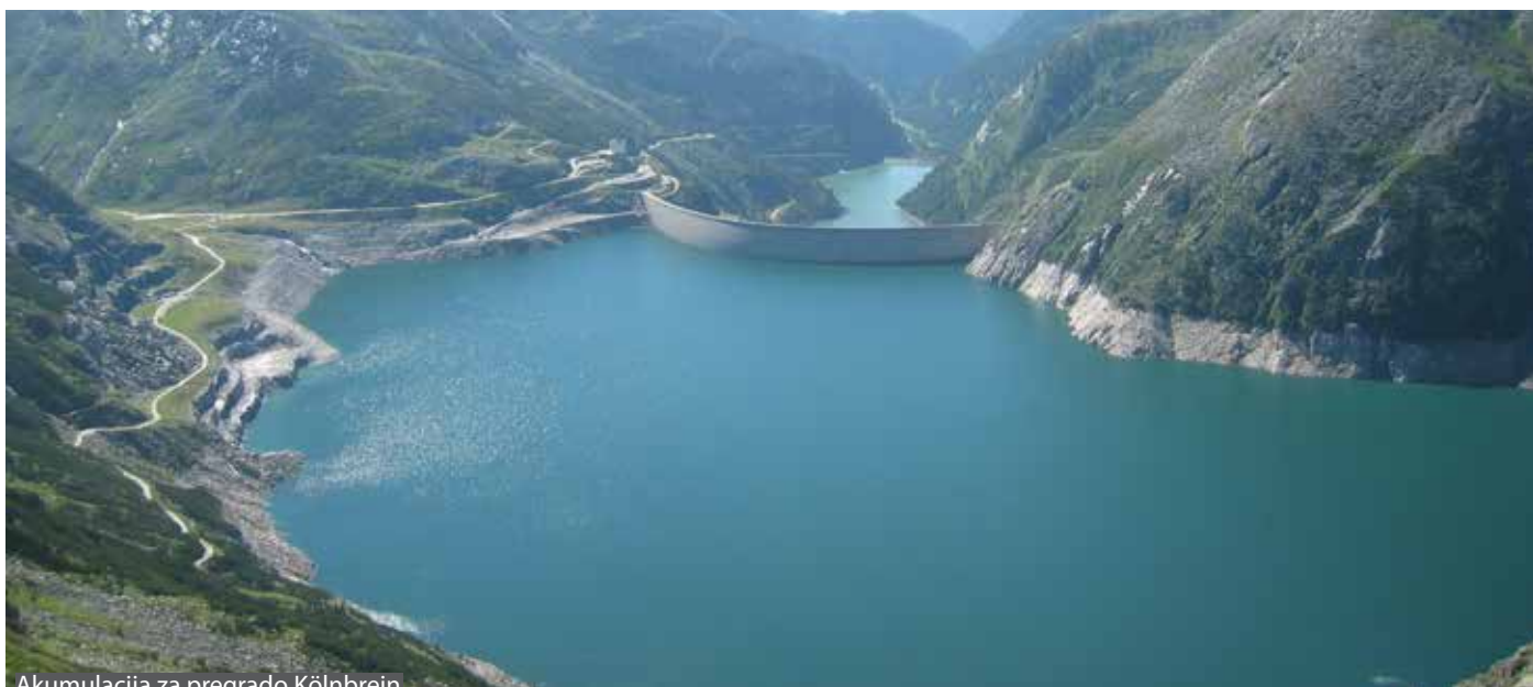
Akumulacija za pregrado Kölnbrein
