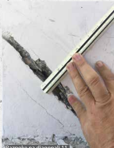
Razpoke na diagonalni 11
