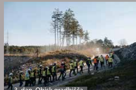
3. dan, Obisk gradbišča
