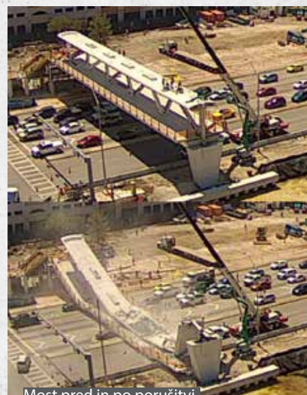
Most pred in po porušitvi
