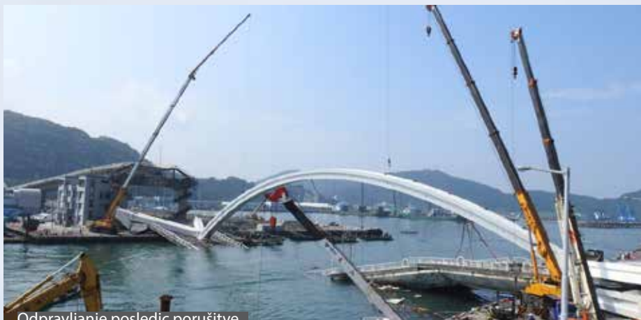
Odpravljanje posledic porušitve
