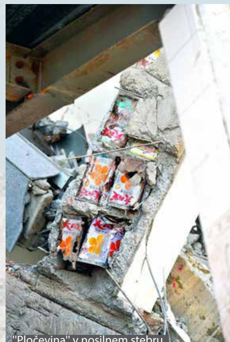
"Pločevina" v nosilnem stebri
