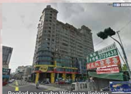
Pogled na stavbo Weiguan Jinlong
