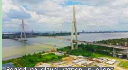
Pogled na glavni razpon in pilone mostu Cần Thơ
