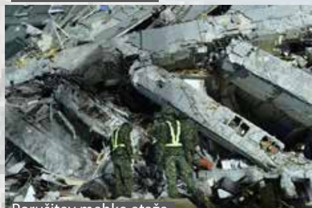
Porušitev mehke etaže
