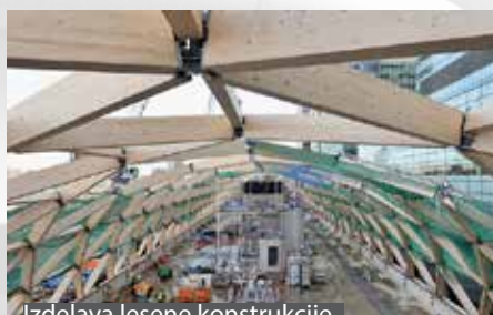
Izdelava lesene konstrukcije
