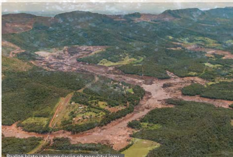
Razlito blato iz akumulacije ob porušitvi jez
