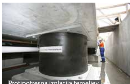
Protipotresna izolacija temeljev
