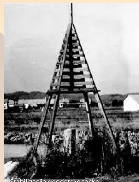
Stabilizacija geodetske točke
