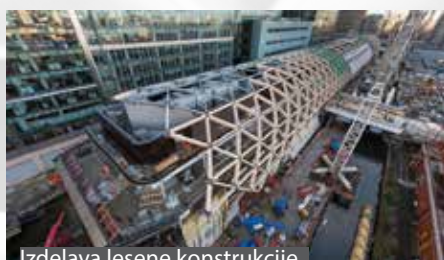
Izdelava lesene konstrukcije
