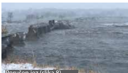
Porušen jez (slika 8)
