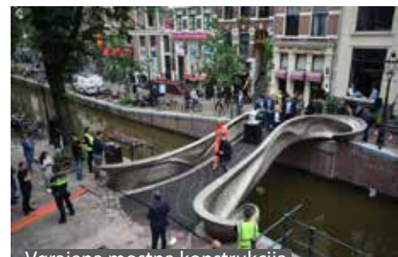
Vgrajena mostna konstrukcija
