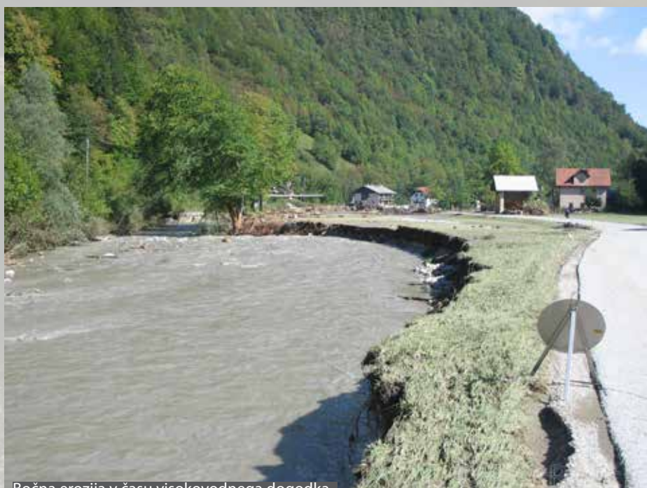
Bočna erozija v času visokovodnega dogodka
