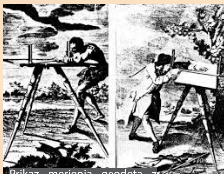
Prikaz merjenja geodeta z mersko mizico.
