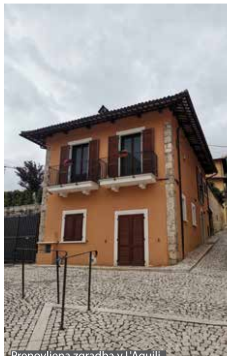
Prenovljena zgradba v L'Aquili
