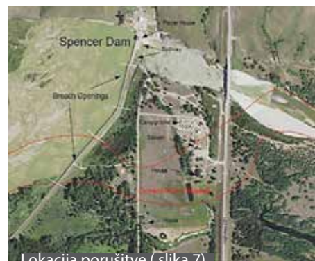
Lokacija porušitve (slika 7)
