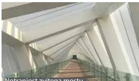
Notranjost zvitega mostu
