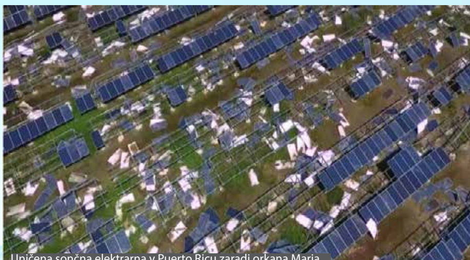
Uničena sončna elektrarna v Puerto Ricu zaradi orkana Maria
