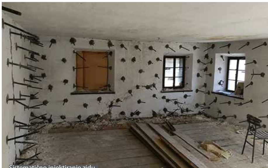
Sistematično injektiranje zidu
