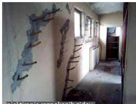
Injektiranje razpokanih zidov
