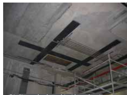
Ojačitve s karbonskimi lamelami
