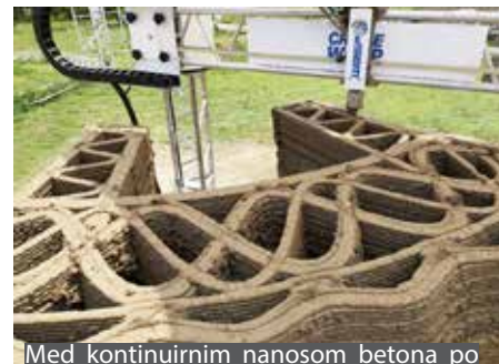
Med kontinuirnim nanosom betona po plasteh
