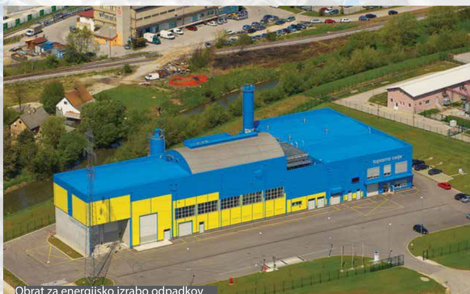
Obrat za energijsko izrabo odpadkov
