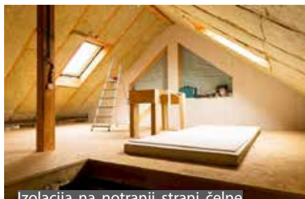
Izolacija na notranji strani čelne stene na podstrešju
