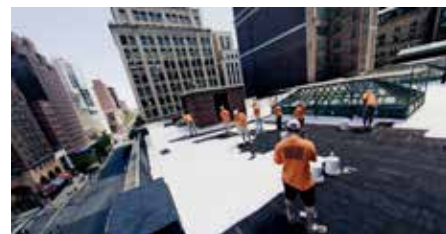
Barvanje streh za doseganje nižje akumulacije toplote skozi streho
