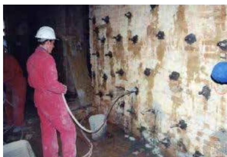
Primer zidu potrebnega sanacije in začetki injektiranja
