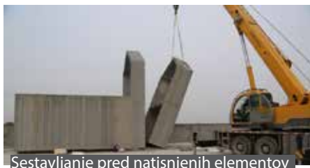
Sestavljanje pred natisnjenih elementov
