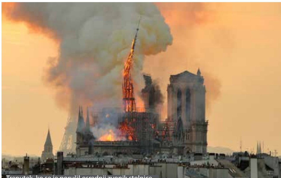
Trenutek, ko se je porušil osrednji zvonik stolnice
