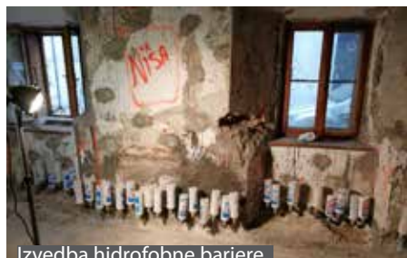
Izvedba hidroforobne bariere
