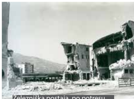
Železniška postaja po potresu
