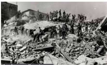
Škoda zaradi potresa
