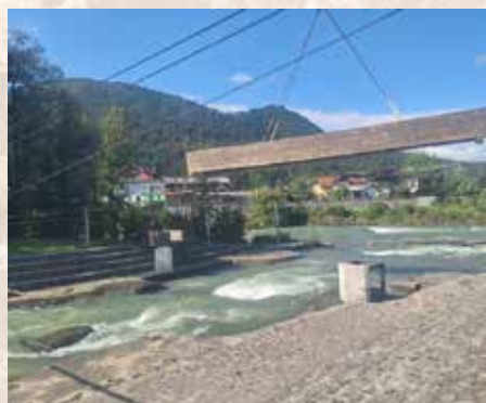
Odstranitev montažnega mostu 3. 8. 2023, pretok 134 \text{ m}^3/\text{s} (Avtor: Gašper Vrabič)
