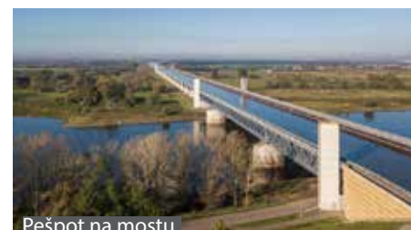
Pešpot na mostu
