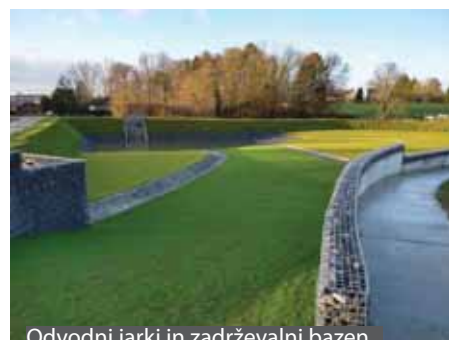
Odvodni jarki in zadrževalni bazen
