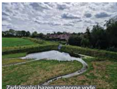
Zadrževalni bazen meteorne vode
