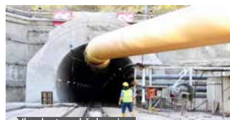
Vhod v tunel železnice
