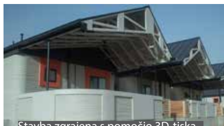
Stavba zgrajena s pomočjo 3D-tiska
