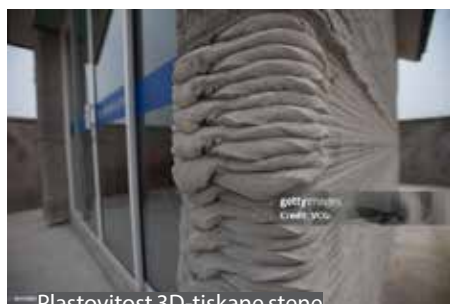
Plastovitost 3D-tiskane stene
