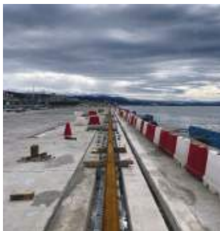
Postavljena tirnica na pristaniškem delu terminala
