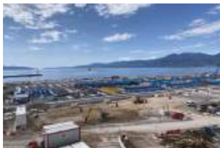
Bodoči kontejnerski terminal Rijeka Gateway v gradnji
