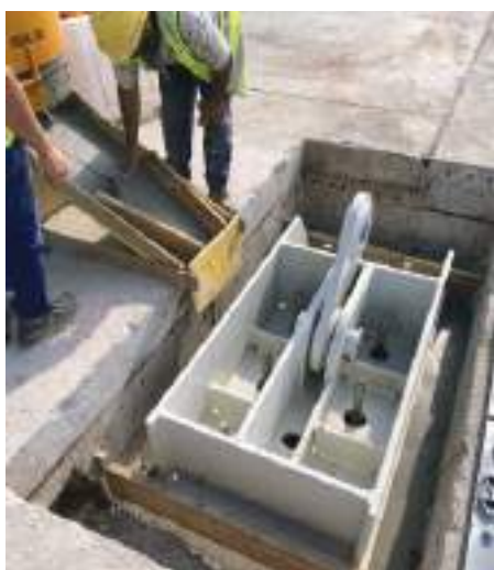
Zalivanje jeklenih tie down elementov s cementno malto
