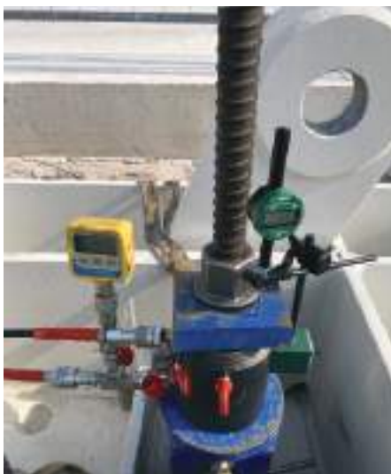
Napetostno testiranje in prednapenjanje navojnih palic
