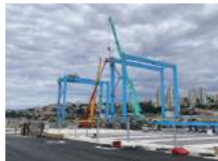
Montirana in dvignjena RTG žerjava
