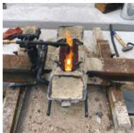
Aluminotermično varjenje na stiku dveh tirnic
