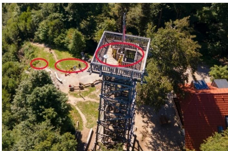
Slika 5: Vertikalni profil motenj na lokaciji Stara Vrhlike. Zgornja kovinska konstrukcija ograje in drog za zastavo sta bila ozemljena, kar je povzročilo nepričakovane motnje.
