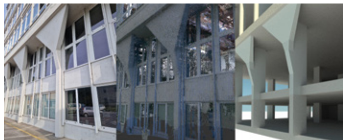
Primerjava dejanskega stanja stebrov (levo), oblaka točk (sredina) in BIM-modela (desno) (Blaž Zupančič)
