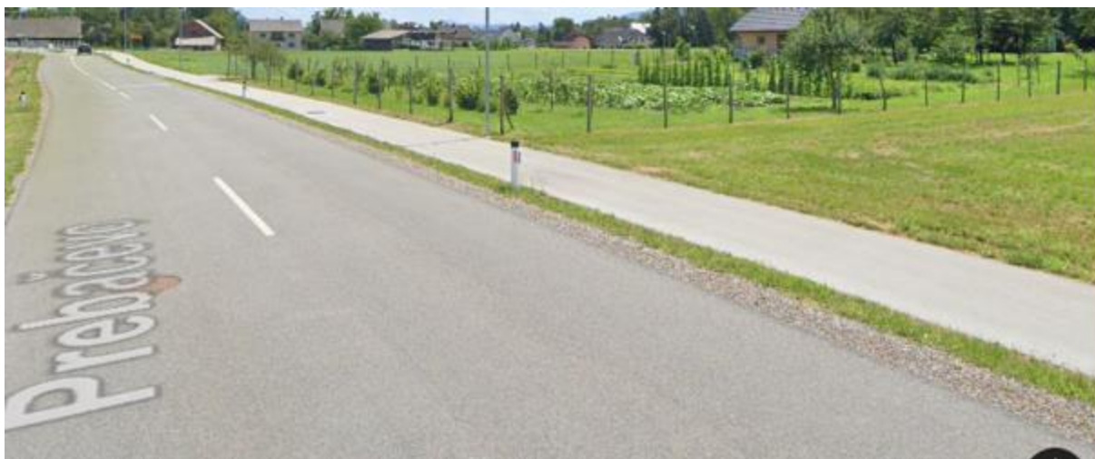
Slika 32: Ustrezno urejena enostranska ločena kolesarska steza na odseku Trboje – Prebačevo (Google Street View, 2022).
