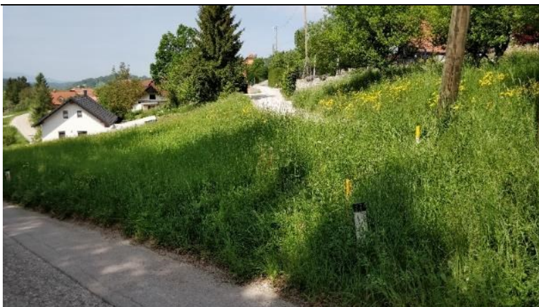
Slika 28: Določitev »zoba« na terenu; označena s količki in geodetsko izmerjeni položaji.
