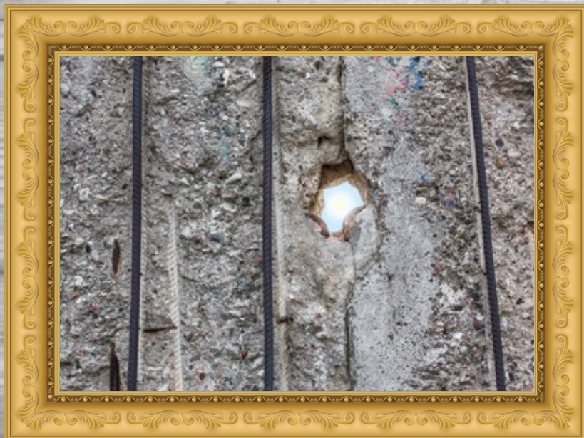
Slika 2: Armatura v betonu (Vir: Bernd Scheumann s Pixabay)
