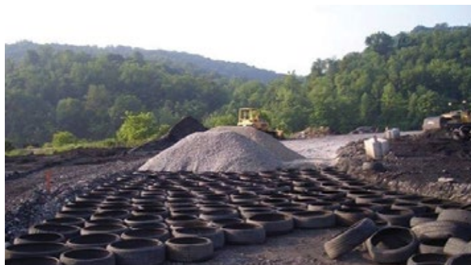
Slika 5: Mehanski beton v gradnji, [5]
