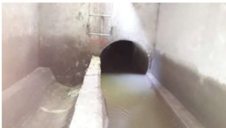
Slika 5: Razbremenilnik Jadranska R40 (Vir: MIMOS, meritve, merilna oprema in svetovanje)
