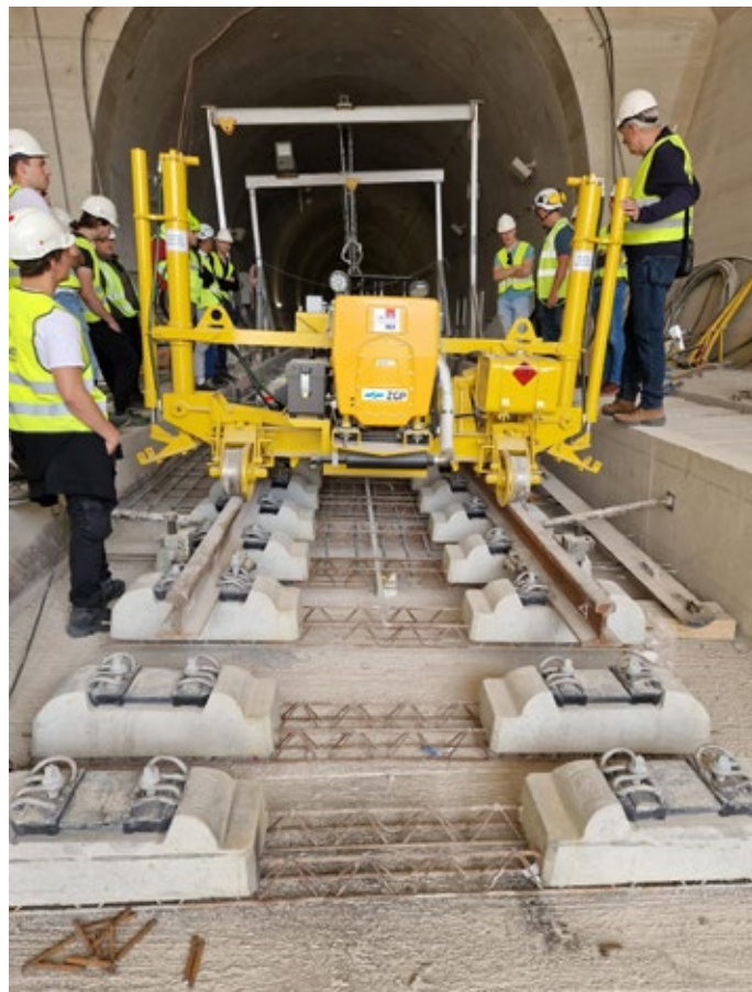
Slika 5: Stroj za vgradnjo tira po sistemu toge podlage (vir: Urška Žonta)
