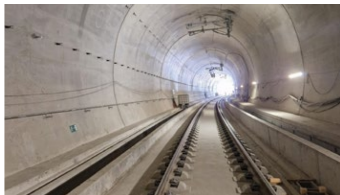
Slika 3: Tir na togi podlagi, predor T8 (Vir: Urška Žonta)
