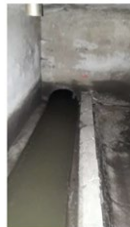
Slika 5: Razbremenilnik Jadranska R40 (Vir: MIMOS, meritve, merilna oprema in svetovanje)
