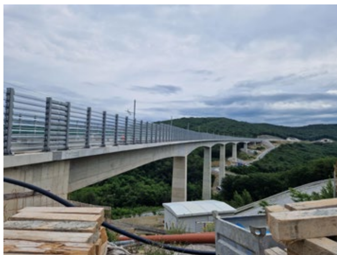
Slika 6: Viadukt Vinjan, pogled proti predoru Mlinarji (T7) (vir: Urška Žonta)
