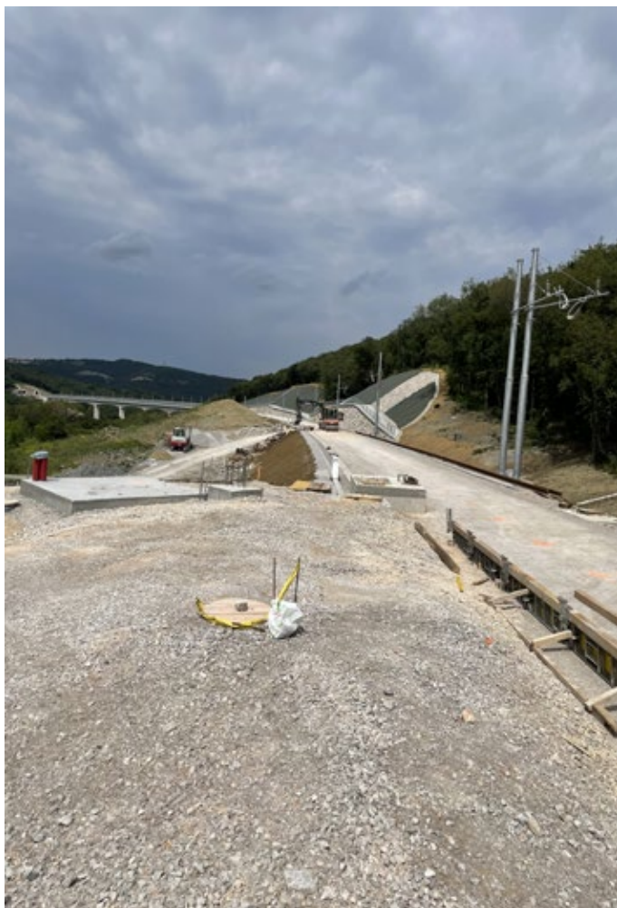
Slika 7: Viadukt Vinjan, pogled proti predoru T8 (vir: Miha Majnik)
