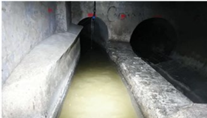
Slika 1: Razbremenilnik Hajdrihova R39 (Vir: MIMOS, meritve, merilna oprema in svetovanje)
