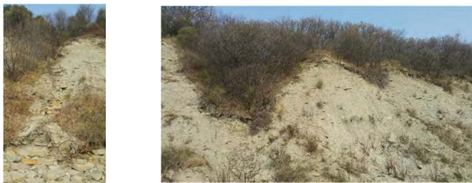
Slika 4.2: Erozijski kanali na klifu in akumuliran material na vznožju (levo). Ploskovna erozija na klifu (desno).
