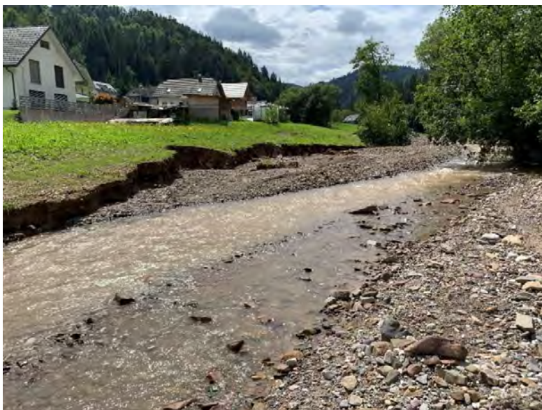
Slika 9.45: Bočno erodirane brežine in zasuta struga po poplavni ujmi avgusta 2023 v spodnjem toku obravnavanega odseka Hrastnice, približno 150 m dolvodno od prečnega profila P1 (Foto: T. Dolenc, avgust 2023).
