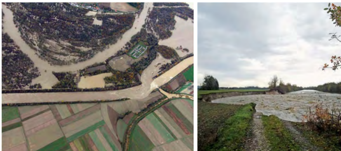
Slika 5.5: Poškodbe brežin na odseku preboja reke Drave v odvodni kanal HE Formin (Vir: Mensuras, d. o. o., ARSO).
