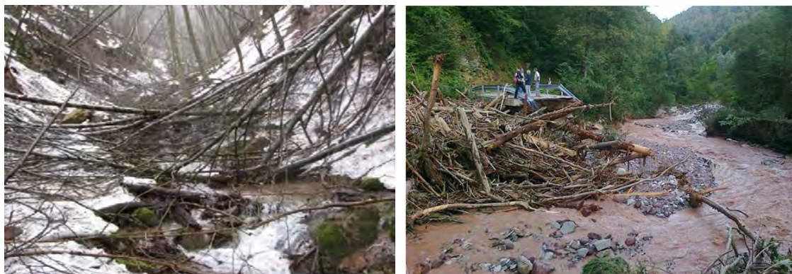
Slika 5.3: Zaradi žledu poškodovana drevesa na območju hudournika Kuzlovec, ki so predstavljala potencialni dotok plavja za reko Gradaščico (levo). Porušen most na cesti proti Selu nad Polhovim Gradcem zaradi zagozdenega plavja ob mostno odprtino (desno).
