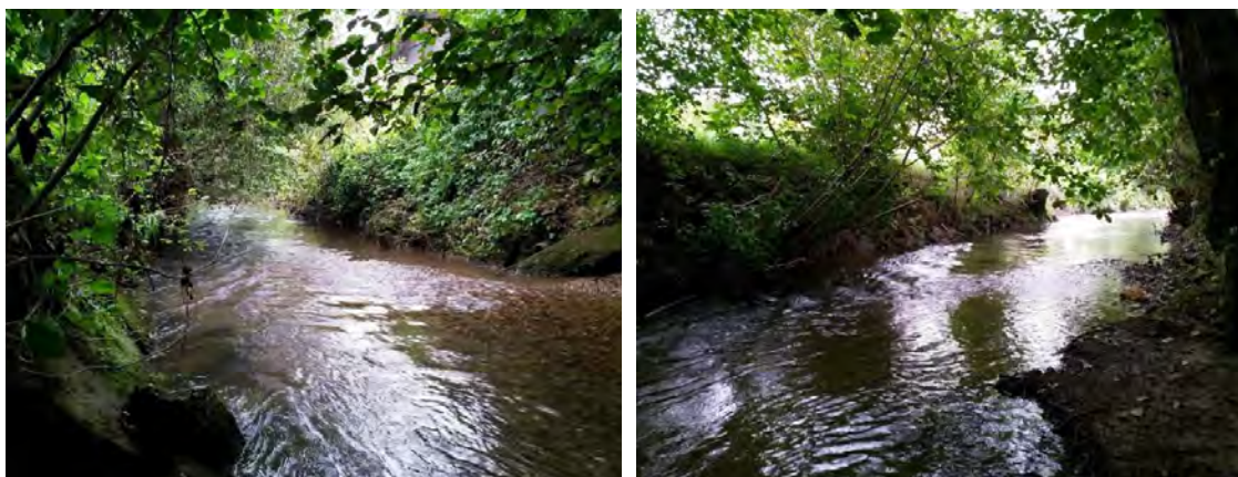
Slika 9.3: Preraščenost struge Dobrunjščice z grmovno in drevesno vegetacijo (levo) in lokalne erozijske zajede in nanosi plavin v strugi (desno).
