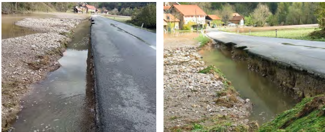
Slika 8.10: Primeri erozijskih zajed pri prelivanju poplavnih voda preko posameznih sprememb v topografiji terena (npr. cestnih nasipov) na območjih poplavnih območij (viri zgornjih dveh slik: siol.net, rtvslo.si).
