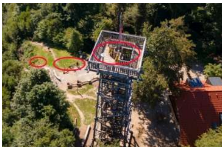
Slika 5: Vertikalni profil motenj na lokaciji Stara Vrhlike. Zgornja kovinska konstrukcija ograje in drog za zastavo sta bila ozemljena, kar je izboljšalo prenos motenj do sicer za motnje zasenčenega vznožja stolpa.
