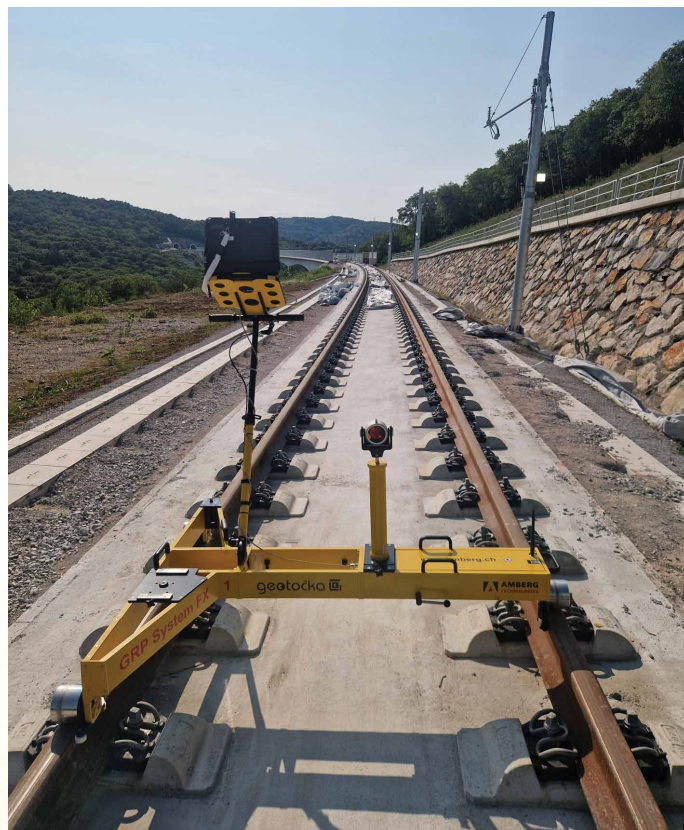
Slika 6: Izmera tira po betonaži (Ana Starc)
