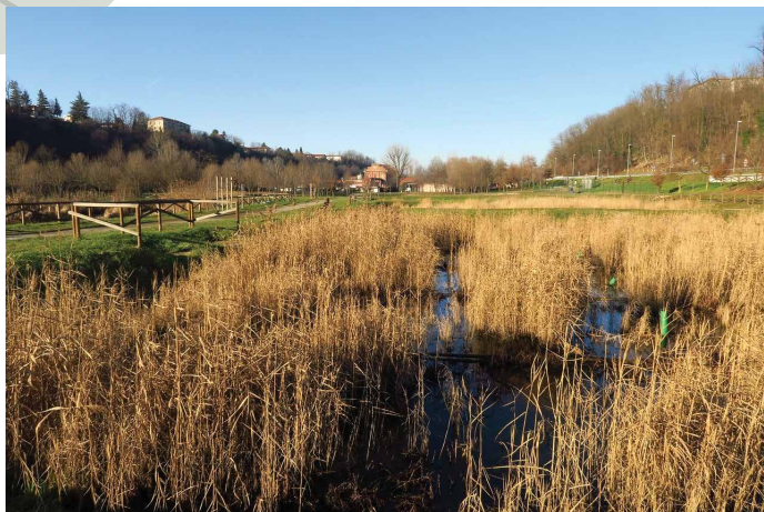
Slika 1: Primer naravne čistilne naprave s prosto gladino (Vir: gepego s Pixabay)
