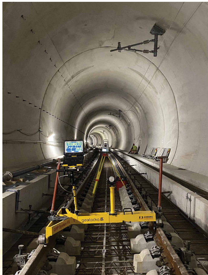
Slika 3: Postavitev merilnega vozička in tahimetra (Ana Starc)
