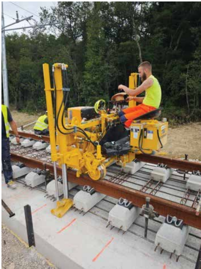
Slika 2: Zakoličba osi in višine tira ter prvi dvig tira s hidravlično NH napravo (Ana Starc)
