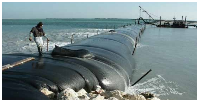
Slika 2: Primer uporabe geo-tub za boj proti eroziji (Vir: [2])
