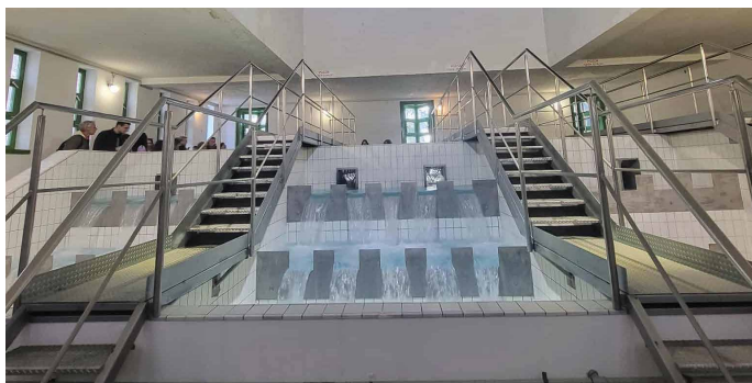
Kaskade za "prevetritev vode"
