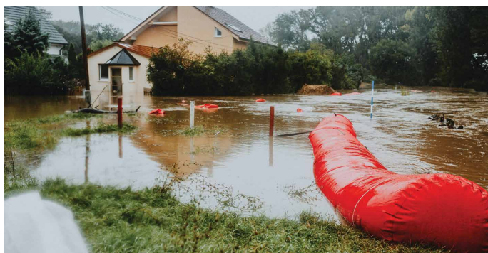
Slika 1: Primer uporabe geo-tub v primeru poplav (Vir: Helen s pexels)
