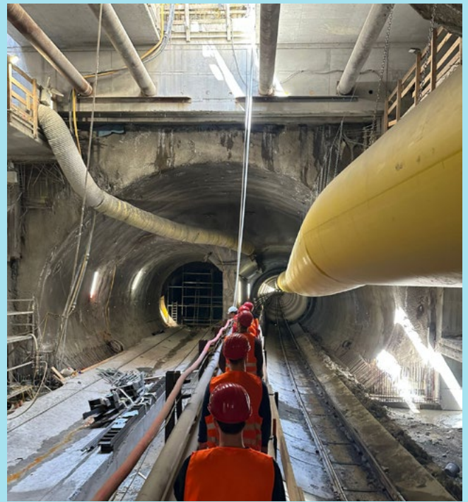
Slika 4: Oglad gradbišča podzemne železnice na Dunaju
