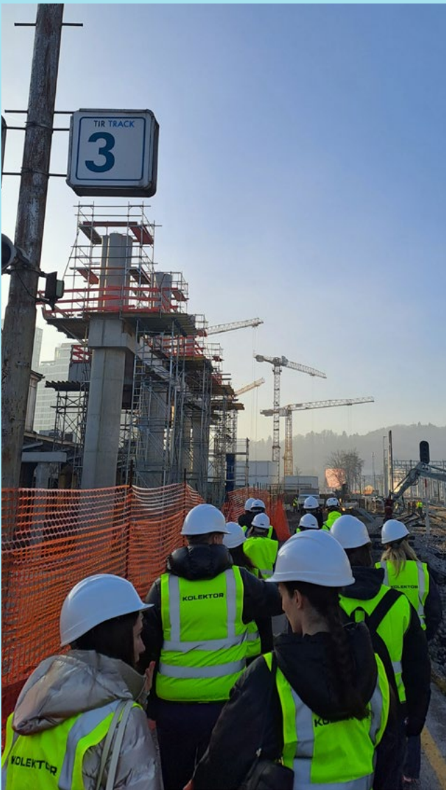
Slika 3: Oglad gradbišča železniška postaja Ljubljana
