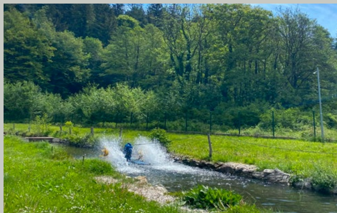
Slika 9: Kanal s kolesi za bogatenje vode s kisikom v ribogojnici (Vir: osebni arhiv)
