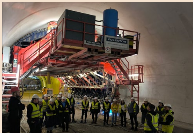
Slika 4: Ogled gradbišča (Vir: osebni arhiv)
