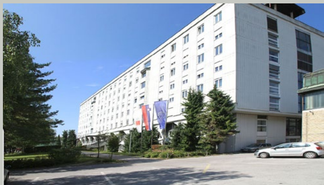
Slika 1: Glavna stavba Fakultete za gradbeništvo in geodezijo na Jamovi 2 [1]
