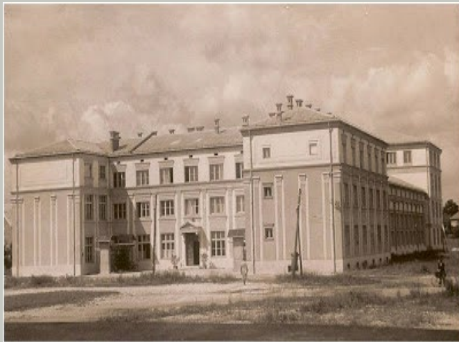
Slika 4: Pogled na Hajdrihovo 28 kmalu po izgradnji [4]
