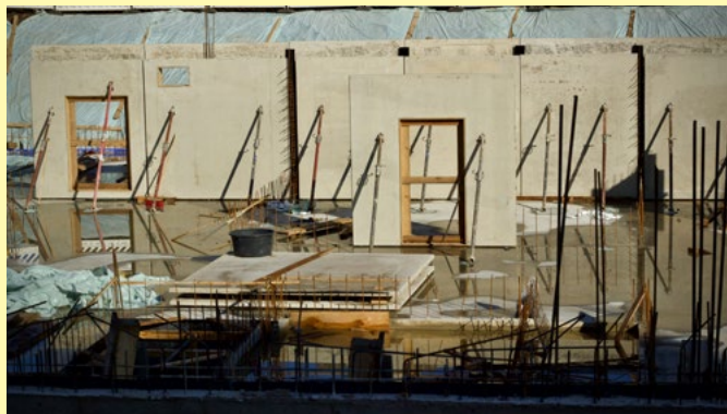
Slika 5: Podpiranje sten in prikaz opaženja odprtin
